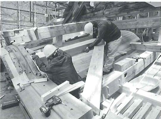
名草神社（兵庫県）本殿唐破風取付工事
